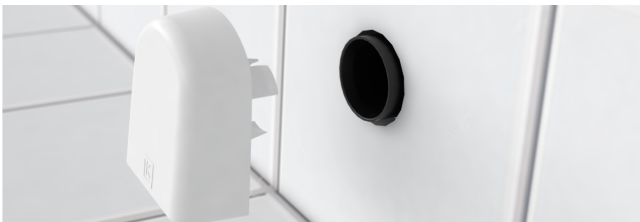
Montering av LK Siklemikk.
