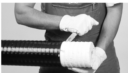
5 Ta bort isolering och eventuella rester längs sträckorna (X, Y, Z). Obs: Skada ej mediaröret!
