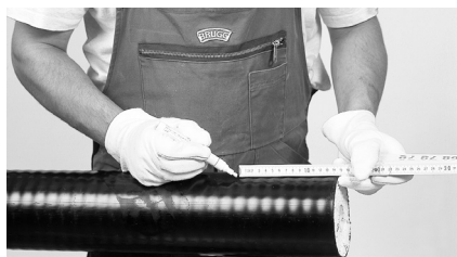
1 Märk ut avstånden (x, y, z) + 1 cm från änden på kulverten.
