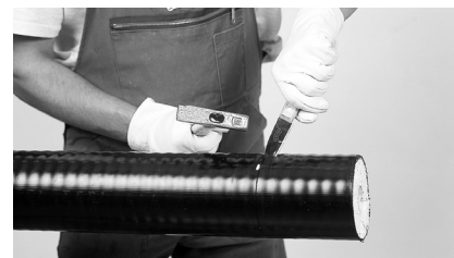
3 Skär upp ytermanteln med en kniv.. Obs: Skada ej mediaröret!
