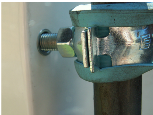
Nærbilde av innfesting mot skap.
