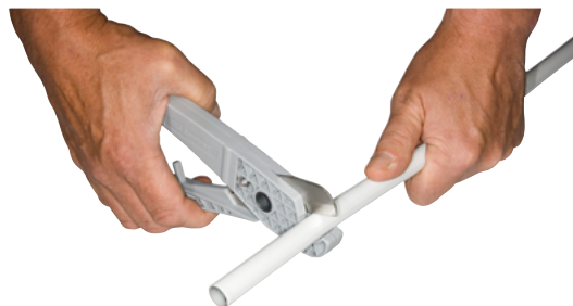
Kapping med rørsaks.
