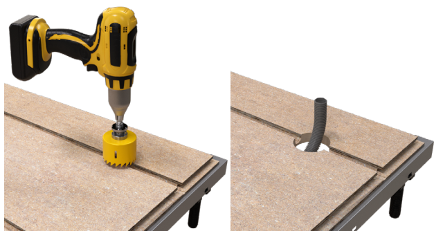
Boret hull i varmegulv 22. Det varerøret er oppdraget gjennom hullet.
