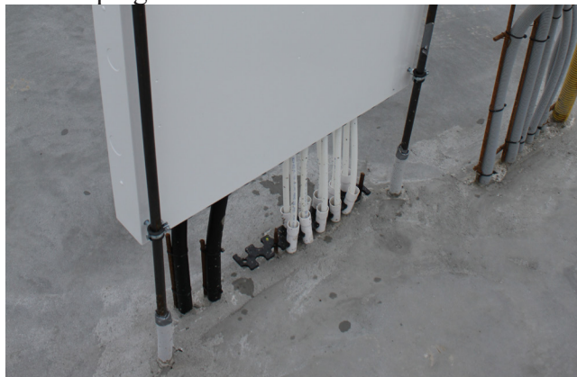
Montert skapstativ L2.
