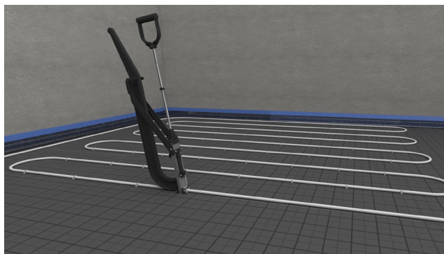
Montasje av rør mot LK Folieplate 30 Silent.
