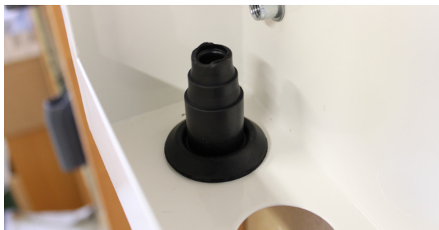
Montere rørgjennomføringen i skapet.
