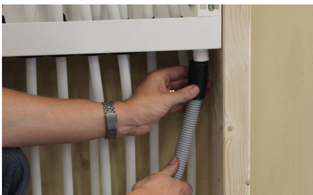
Montere gummimuffen
