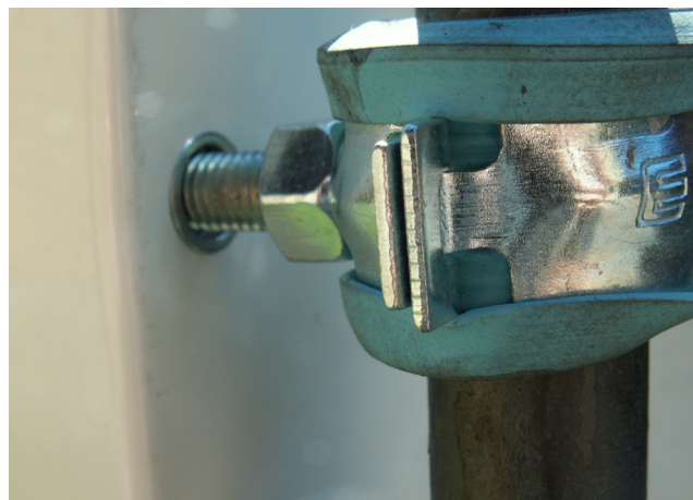
Nærbilde av festing mot skap
