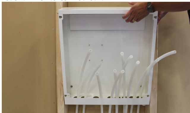
For skapet over rørene.
