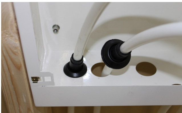
Montere rørgjennomføringene.
