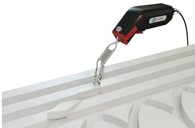
Sporing i EPS celleplastskiver med LK Varmekniv 90 W.
