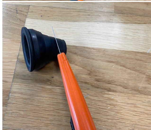
Kapping av LK Rørgjennomføring 20-25 LP . Den skal tilpasses kobberøret til vannutkasteren.
