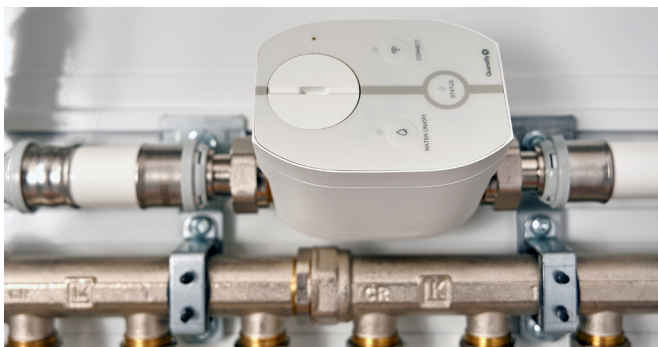
LK CubicSecure installert i et fordelerskap.
