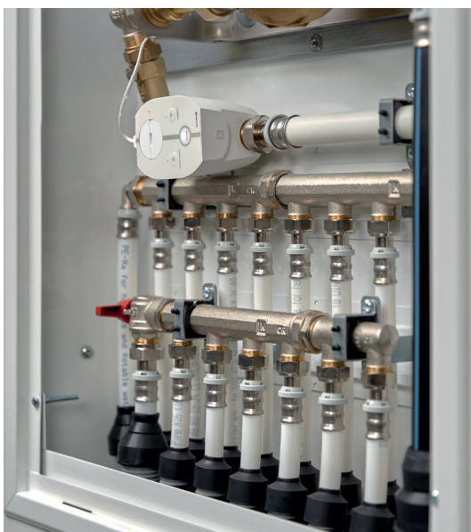
Vannstopper montert i skapet.
