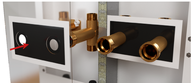
Montering av sprutbeskyttelse.
