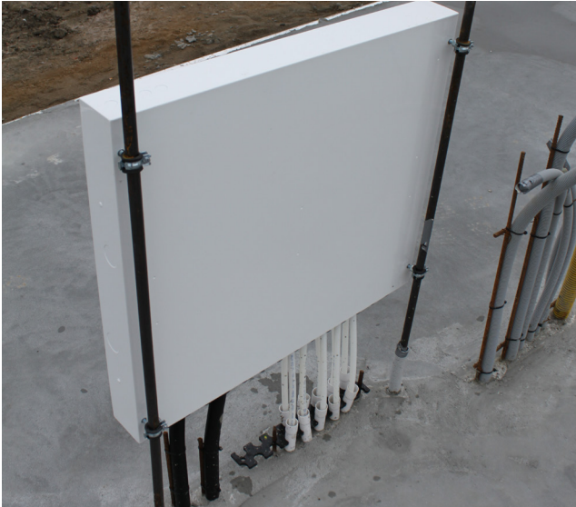
Montert LK Skapstativ L2.
