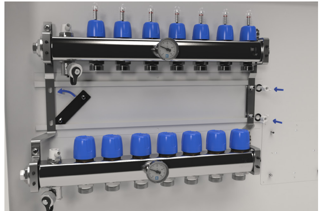
Montering av LK Varmefordeler RF.
