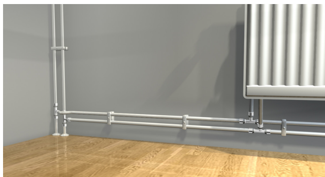
Eksempel på fiksering ved synlig forlegning.
